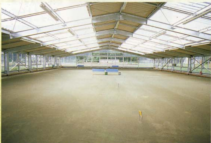
屋内ゲートボール場
